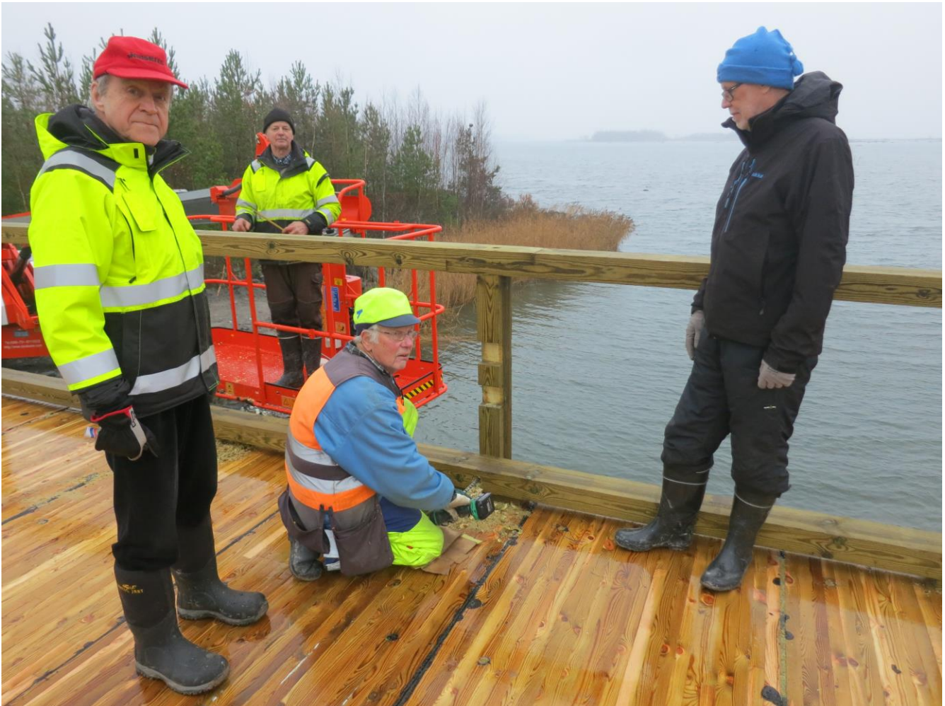
Edessä siltaurakan toteutuksesta vastaava tieisäntä, rkm. Pentti Raekallio
